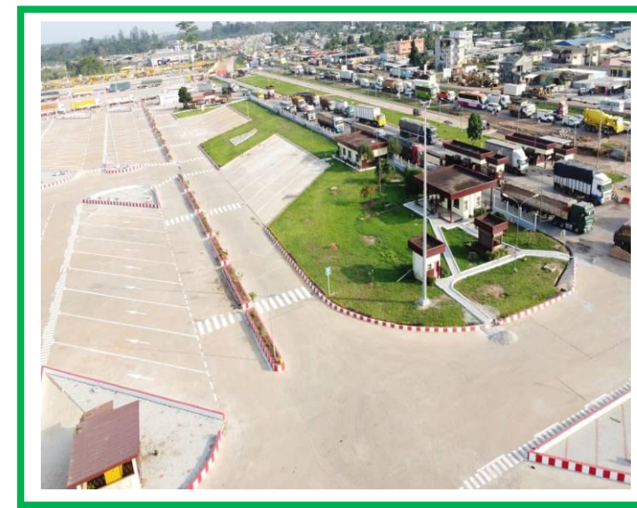
Travaux de construction de l'aire de stationnement d'Allokoï
