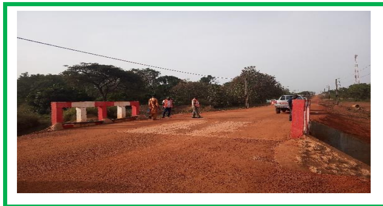
Dalot 4,00x3,00 construit sur l'axe Ponodougou-Kasséré dans le département de Boundiali.
