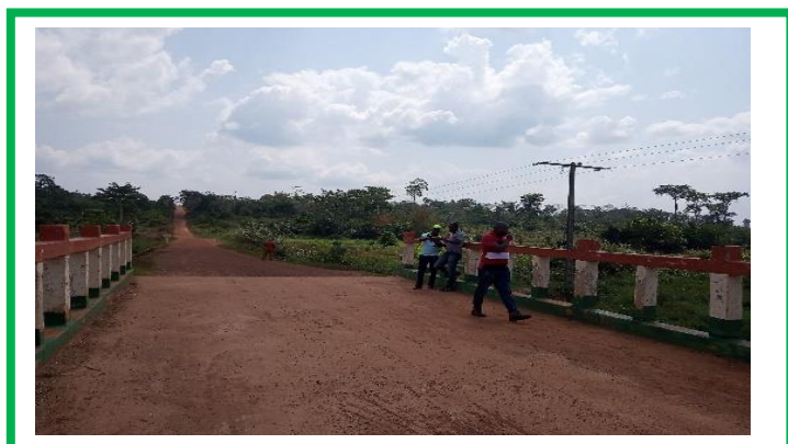
Dalot de dimension 3x4,00x3,00 sur l'axe Balahio dans le département de Ouragahio
