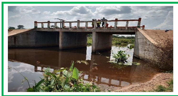
Dalot de dimension 3x4,00x3,00 sur l'axe Balahio dans le département de Ouragahio
