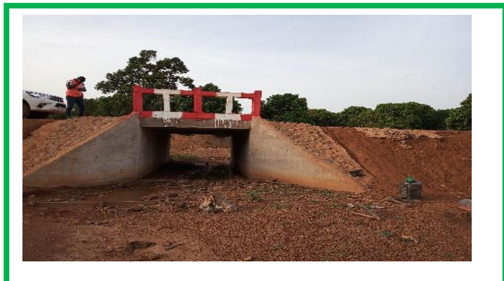
Dalot 4,00x3,00 construit sur l'axe Ponodougou-Kasséré dans le département de Boundiali.
