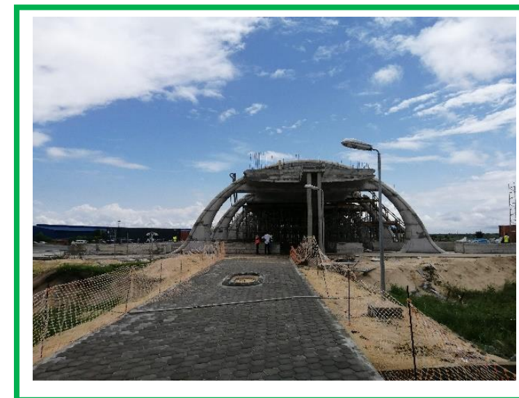
Travaux de la gare de péage de l'autoute Abidjan-Grand Bassam
