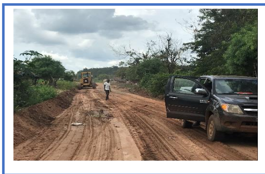
Travaux de reprofilage avec emploi partiel sur les routes en terre en Côte d'Ivoire : itinéraire A5-Wandaghué-Séria-Niouboua
