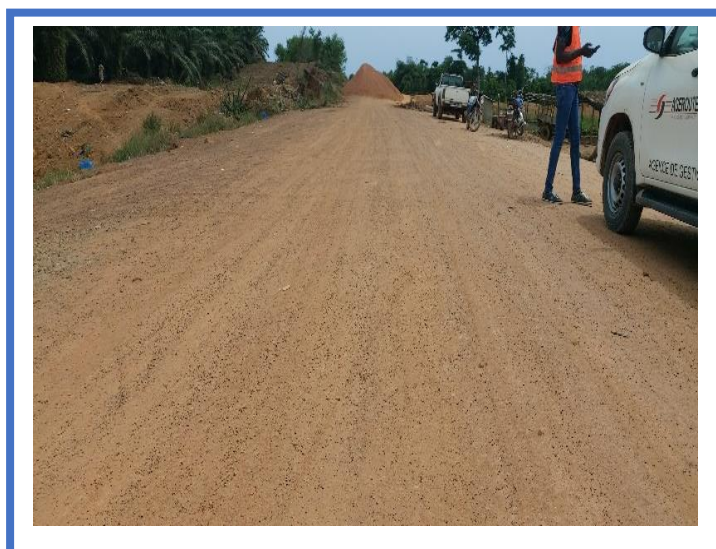
Travaux de traitement de routes sur l'axe Tabou-Dewaké-Néka cité avec les produits hydrophobants ou polymères et assimilé sur l'itinéraire -Tabou-Dewaké
