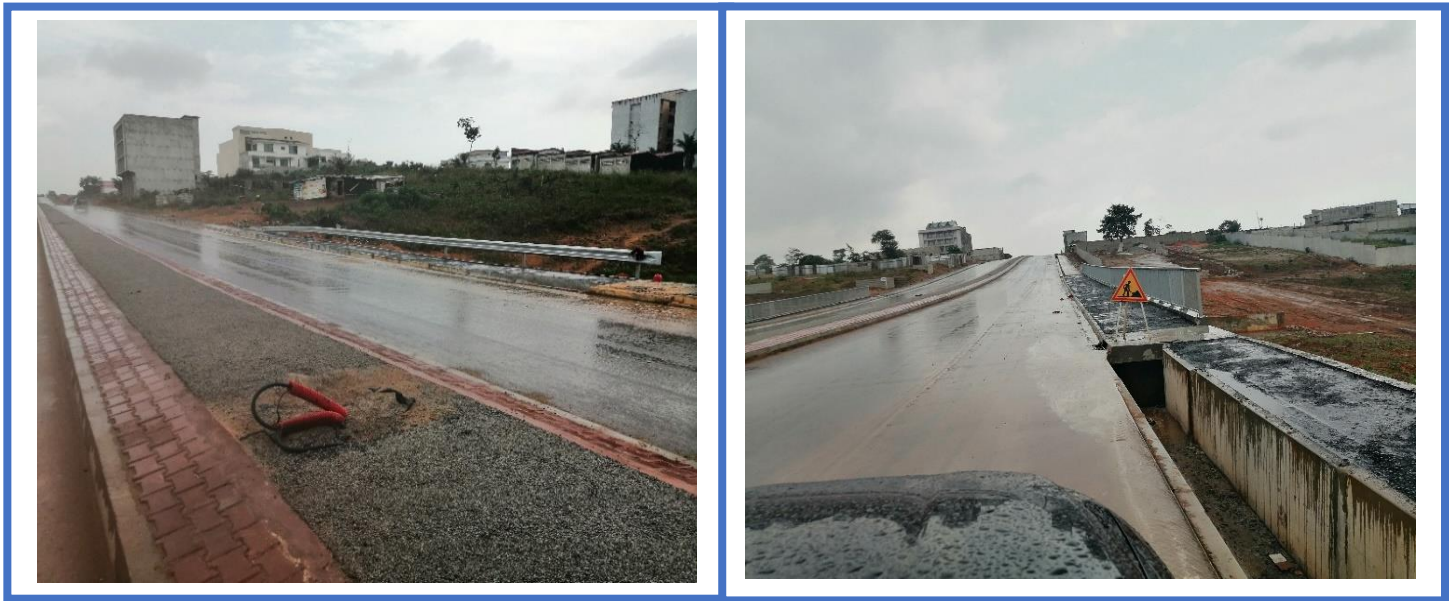
Travaux de voiries et réseaux divers de la cite sir vers le chu d'Angré en 2x2 voies Dans le district d'Abidjan
